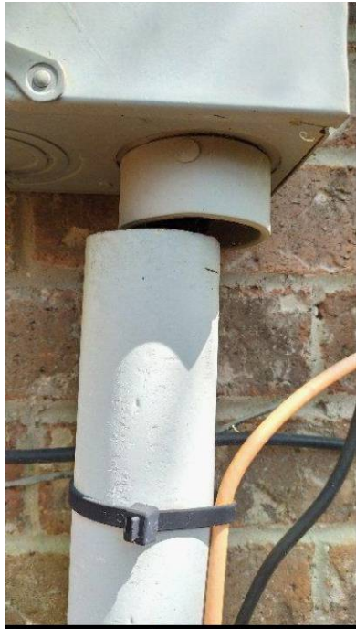
Damaged conduit
