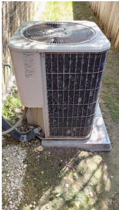
Damaged fins
